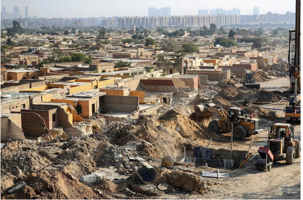
أعمال الهدم في مدينة الموق بالقاهرة القديمة
