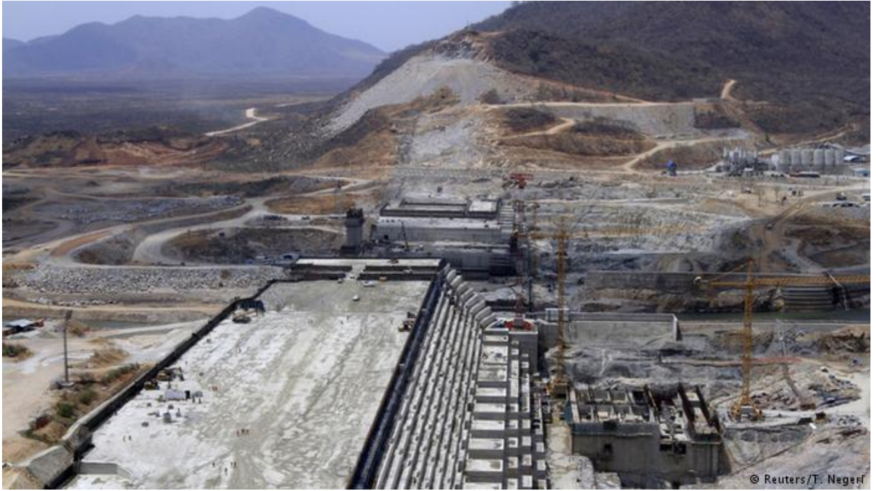
أشغال بناء سد النهضة
