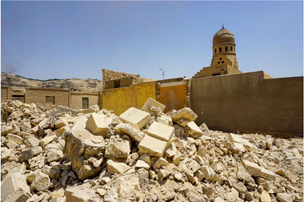
جزء من أعمال الهدم.
