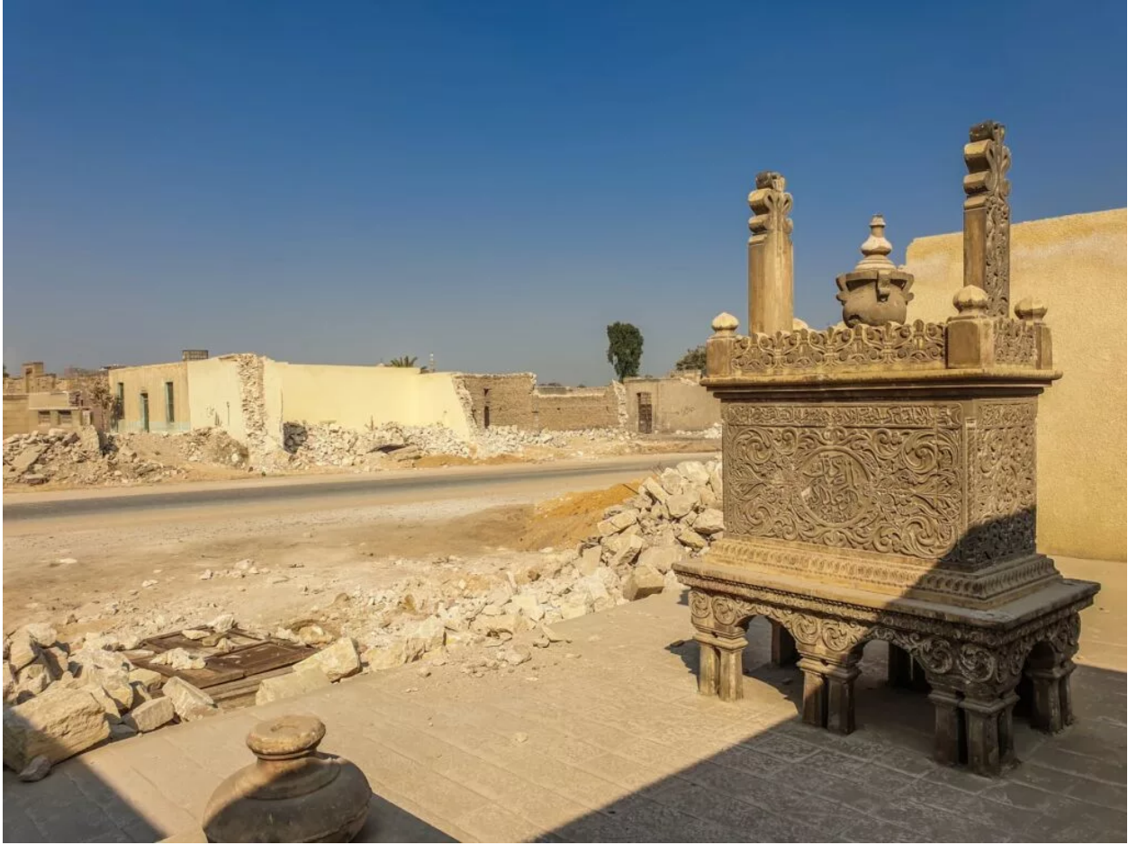
مبنى أثري معزول بعد هدم القبر الذي كان يحويه.
