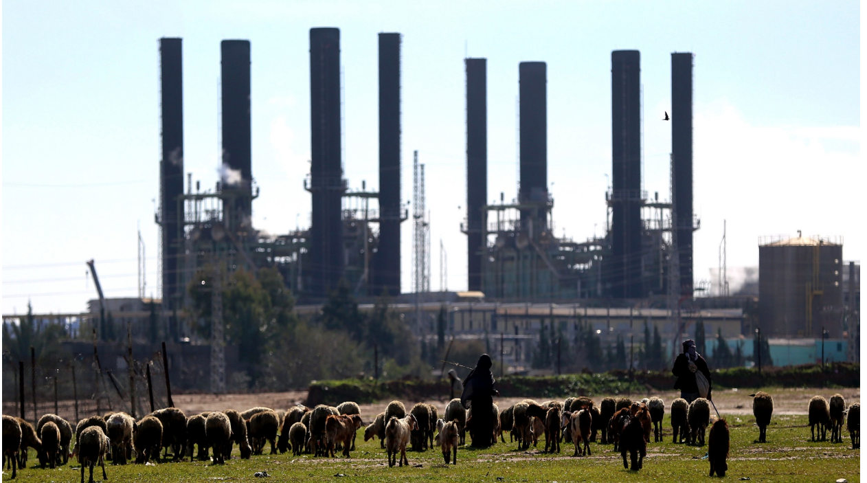
محطة كهرباء غزة
