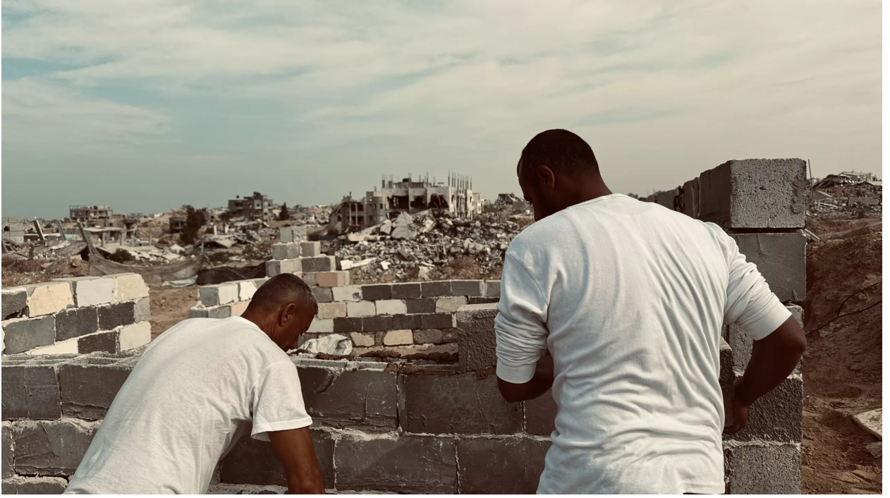
مجدى بركة وهو يبني غرفة من حجارة منزله المدمر بالطين.
