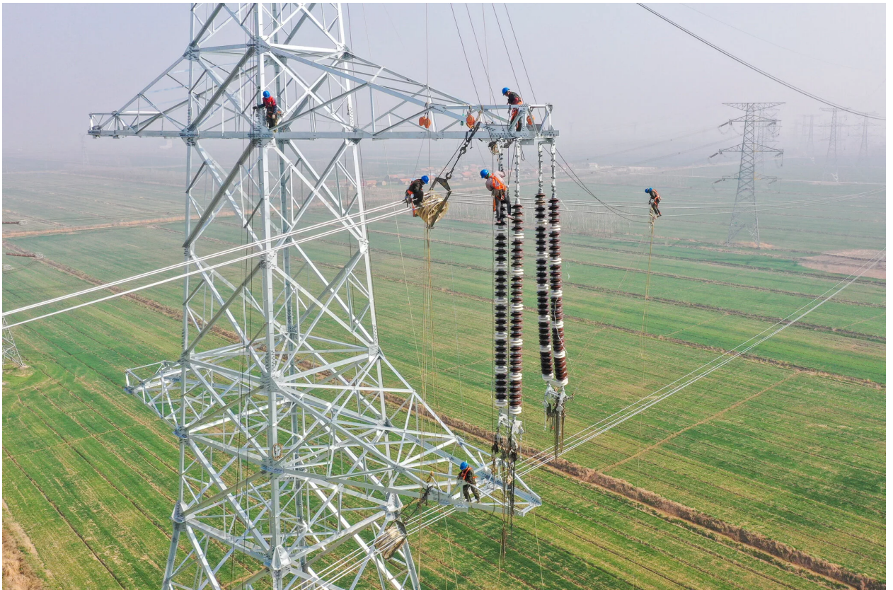
بناء برج نقل للطاقة في محطة تيانوان للطاقة النووية في مقاطعة جيانغسو عام 2023
