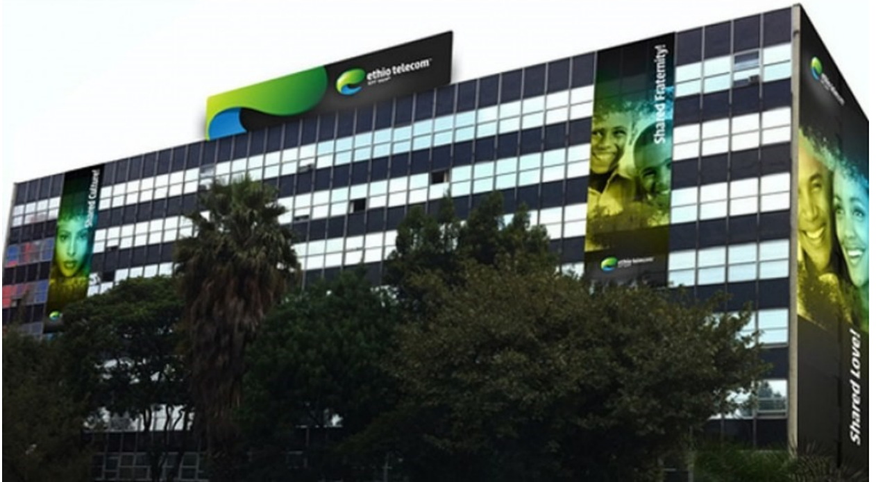
المبنى الرئيس لشركة الاتصالات الإثيوبية “EthioTelecom”
