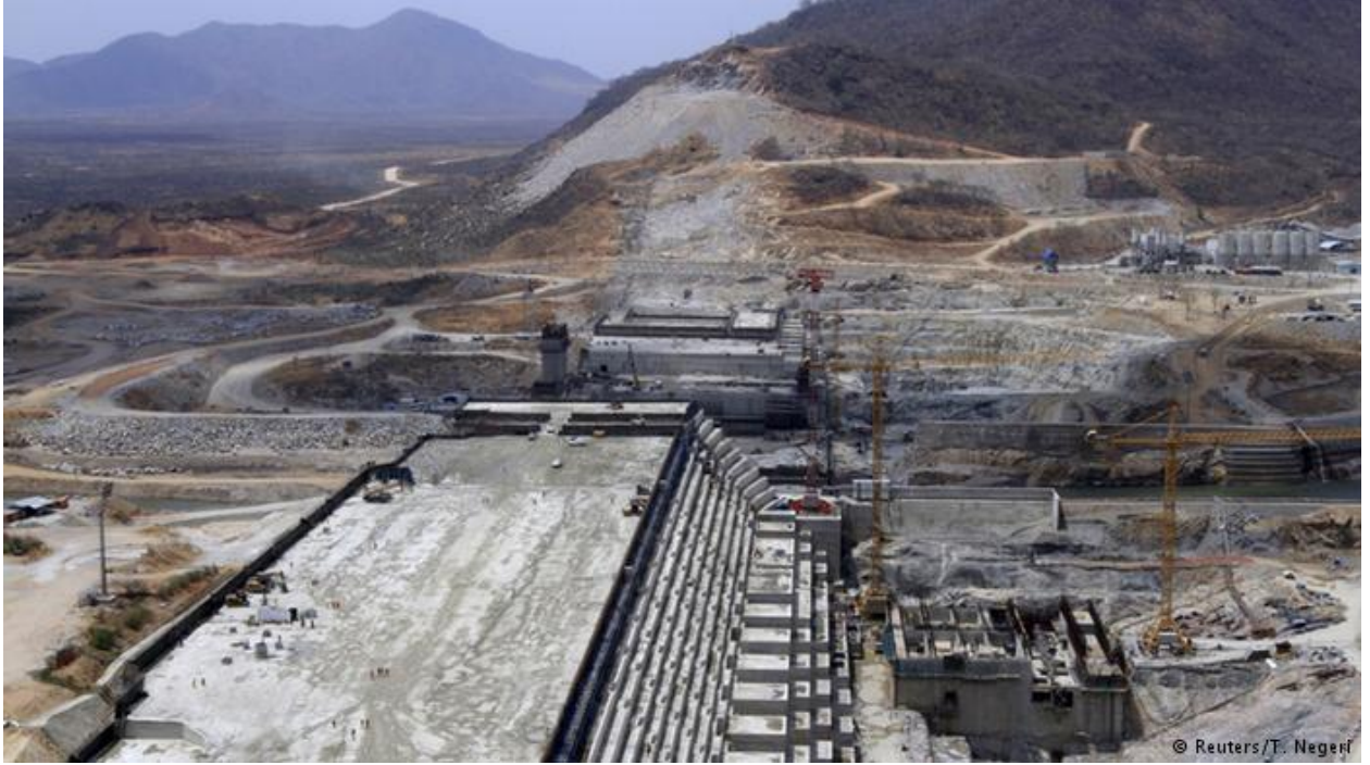
أشغال بناء سد النهضة
