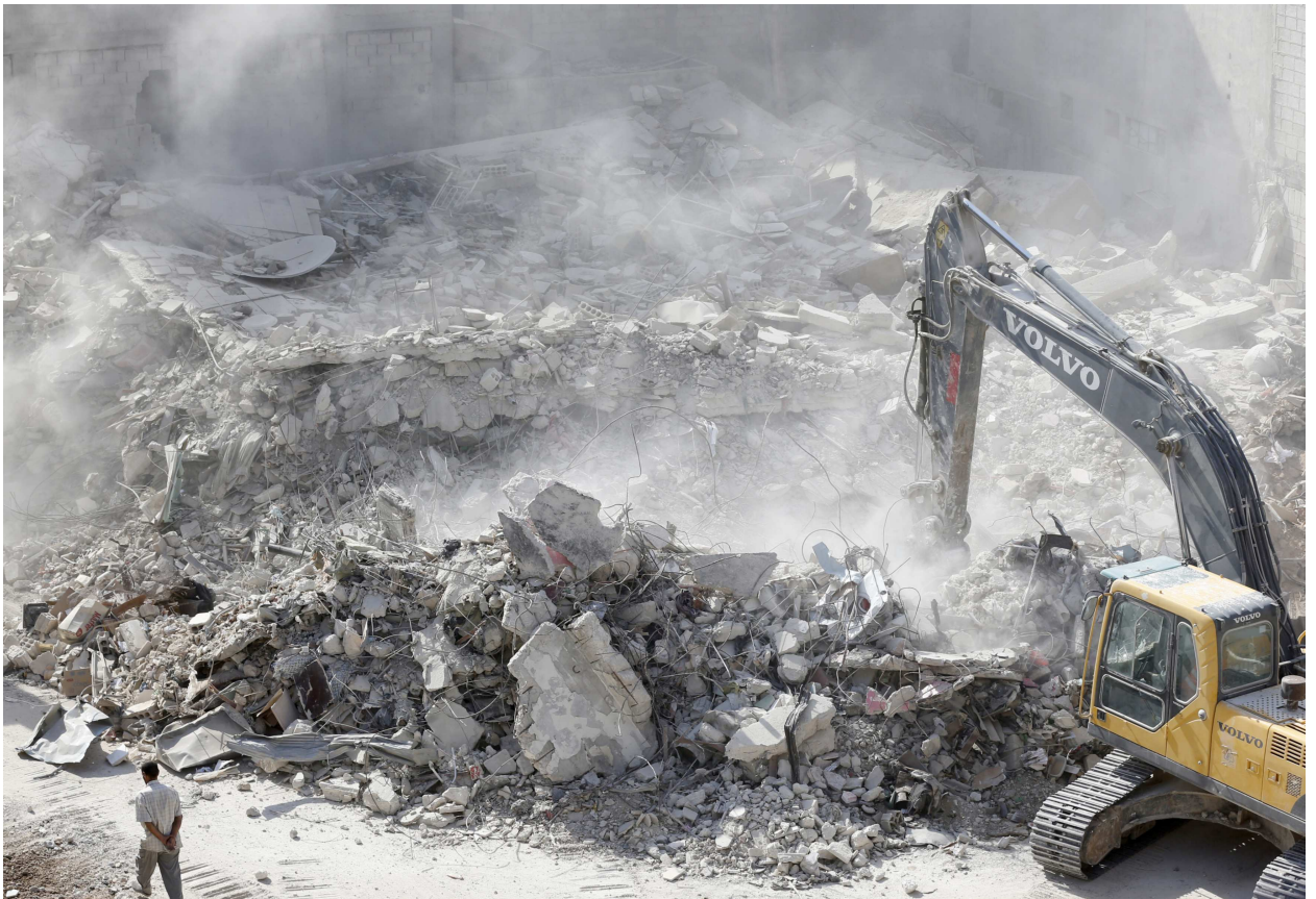
الجرافة تزيل أنقاض المباني المدمرة في حرستا
