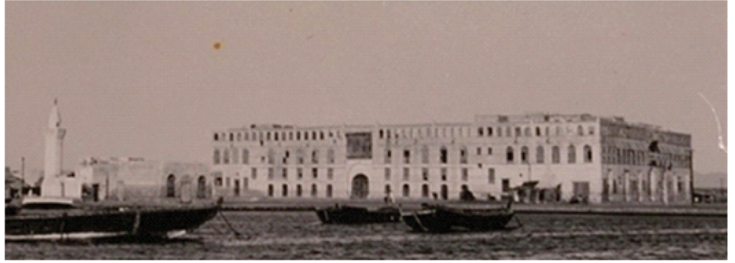
Şennavi Bey Konağı ve Camii (Suvakin)
