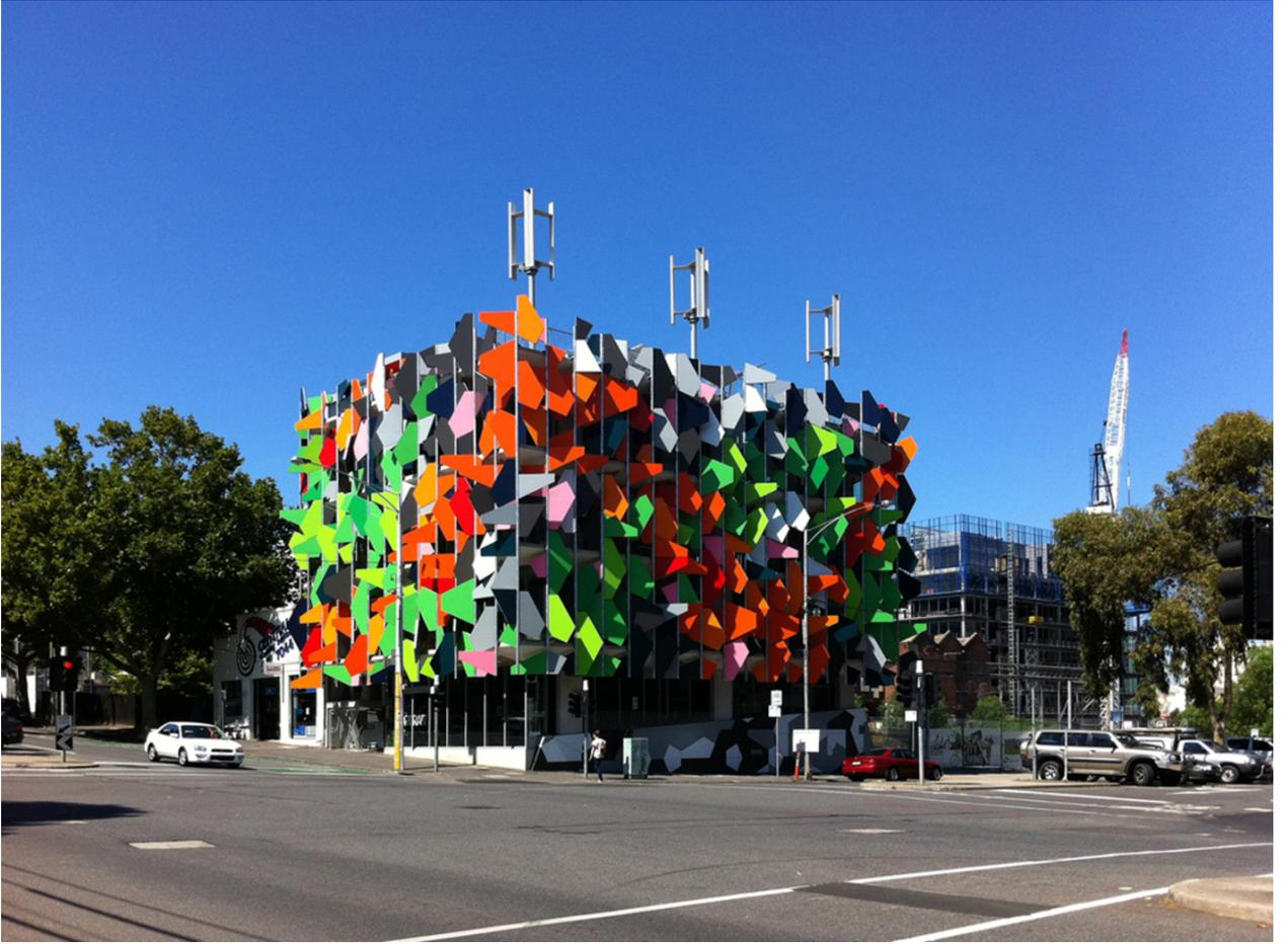
أول مبنى مكتبي خالٍ من الكربون في أستراليا، نشأ كمكتب نموذجي للمستقبل، فليديه سقف أخضر بألواح شمسية لإنتاج طاقته الخاصة ويخزّن كل المياه التي يحتاجها، وتجعل واجهته غير المعتادة متعددة الألوان من الممكن الاستفادة من التهوية والإضاءة الطبيعية لتقليل استهلاك الطاقة.
