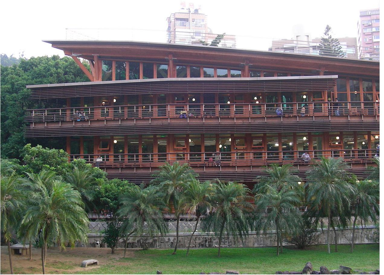
أول مكتبة خضراء في تايوان تقع في بيتو بارك في تايبيه، إنه مبنى من طابقين مصمّم لتقليل استهلاك المياه والكهرباء بفضل النوافذ الكبيرة، والسطح مغطى جزئياً بالخلايا الكهروضوئية لتوليد الطاقة، وكذلك لتجميع مياه الأمطار لاستخدامها في المرحاض.
